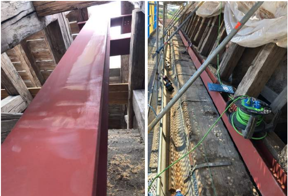
Die Stahlträger sind im Dachstuhl der Mainbernheimer Kirche montiert
