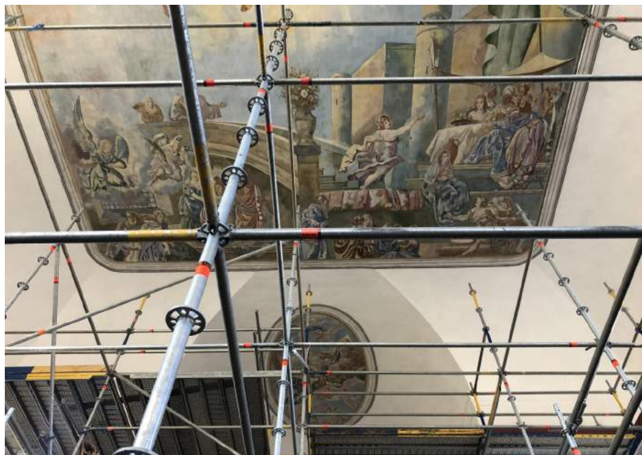
Restauriertes Deckengemälde in Mainbernheim
